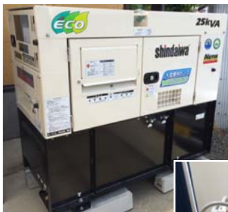
非常用発電機
